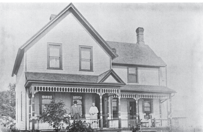
Secunda casa da Vigeli Pally
