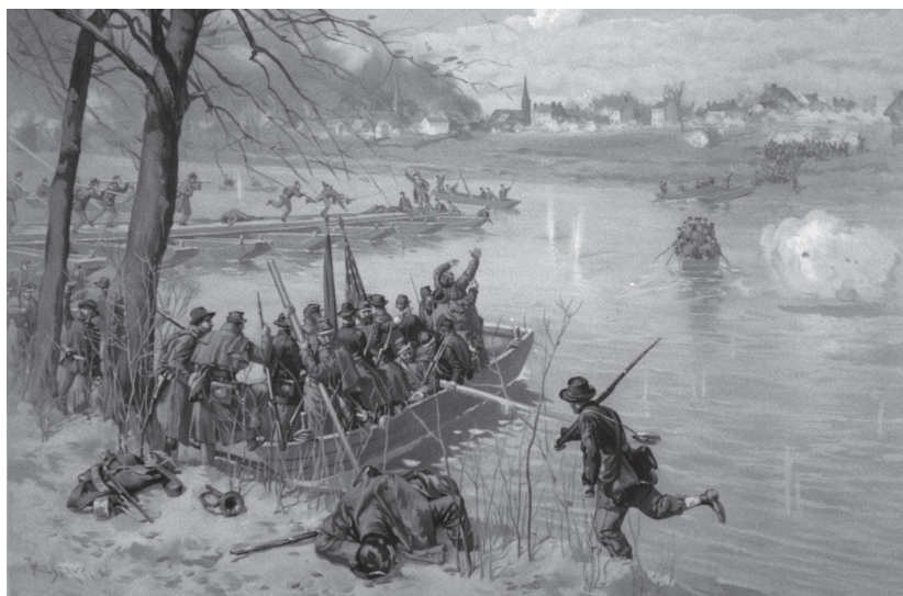
Construcziun dallas punts sur il Rappahannock
