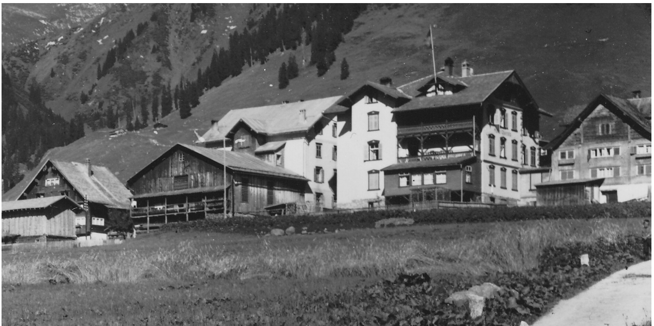
Dretg la veglia casa Muggli, lu il hotel Alpsu suandaus dalla casa digl Adolf Cavegn e seniester la casa pervenda.
