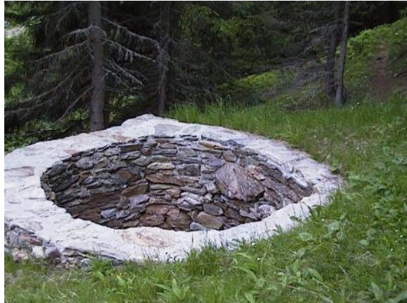
La caltgera restaurada a Pardatsch da vacas
