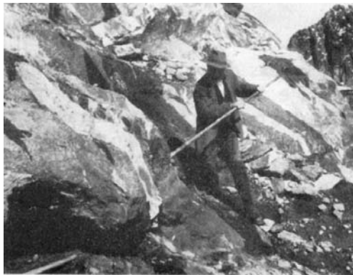
Val Giuf: Las Muttas. Lavur cul palfier. Cunquei che l'aveina d'aplit va tochen giu el funs, impedend cheutras l'explotaziun, sto il toc grep vegnir dismiss.
