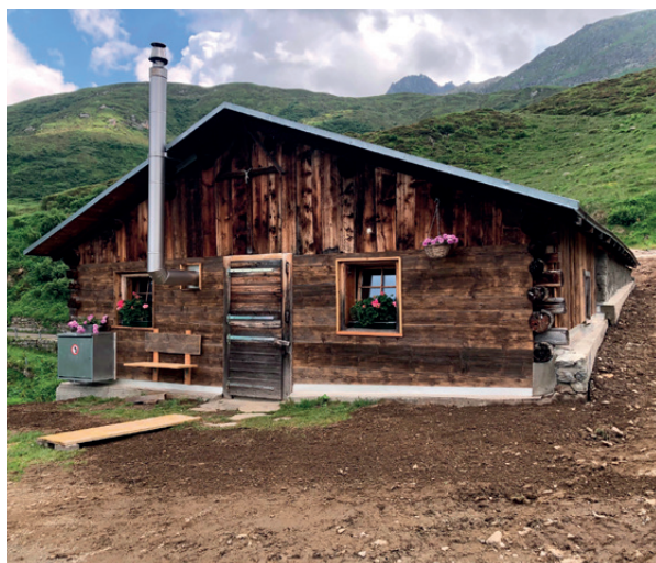
Renovaziuns vid la tegia Crest Stavlaz.
