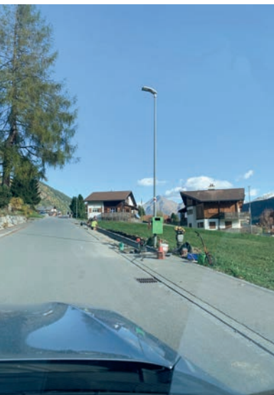
Adattaziuns vid il passapei alla Via dalla Staziun a Camischolas
