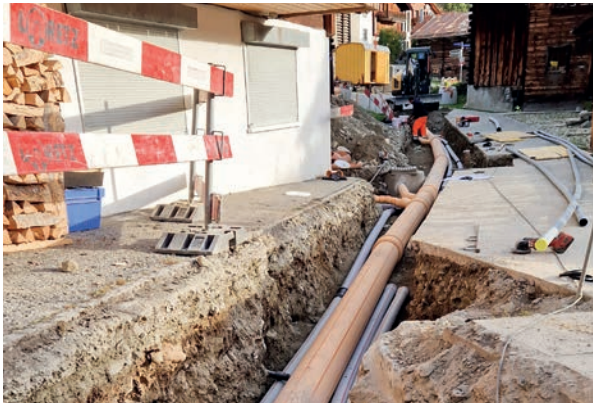
Via Fontauna – Lingia da canalisaziun ed illuminaziun
