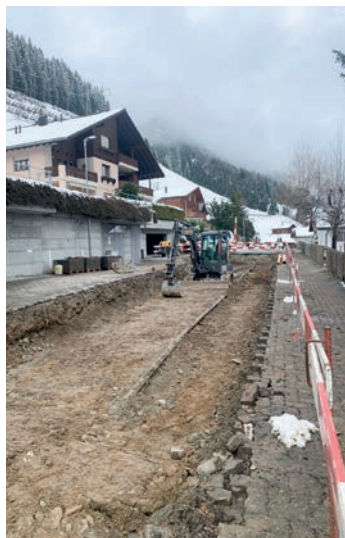
Scavament dalla fundaziun
