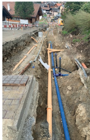
Via Niregl – Nova lingia d'aua da meteo e nova lingia da pressiu per l'aua da beiber
