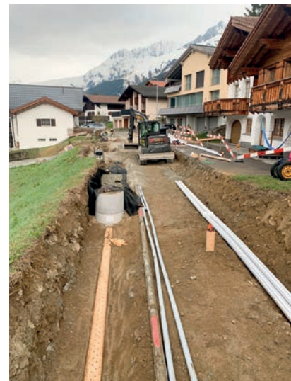
Scavament per las auas piarsas
