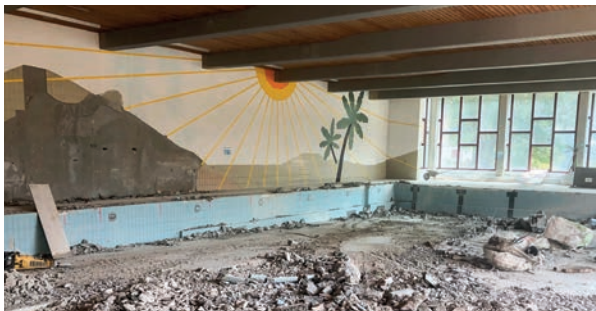
Scavament dil bassin
