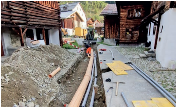
Via Fontauna – Lingia da canalisaziun ed illuminaziun
