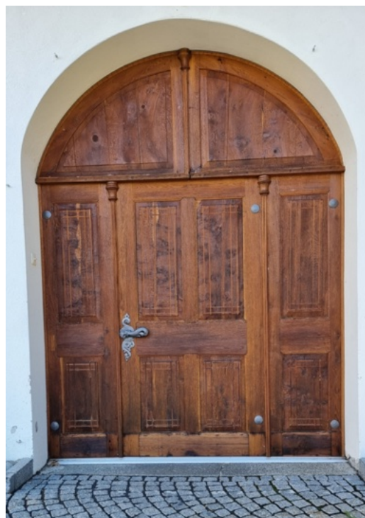
Entrada principla dalla baselgia da s.Vigeli suenter la restauraziun
